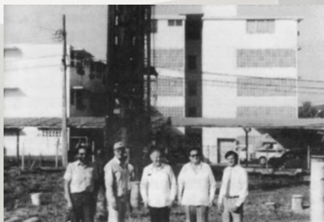
Colocación de los primeros pilotes.
